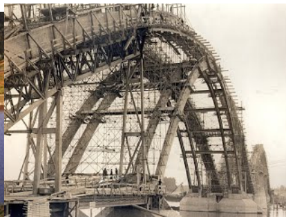
Slika 6. a) – Originalni Žeželjev most preko Dunava u Novom Sadu porušen 1999. godine; b) – Građenje istog mosta na „skeli“ u vidu pomoćnog betonskog luka
