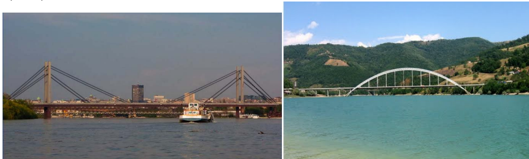
Slika 11. a) – Novi železnički most preko Save u Beogradu; b) – Most „Gazivode“
