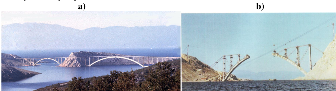
Slika 10. a) – Izgled završenog mosta Kopno – Krk; b) – Građenje lukova istog mosta bez skele
