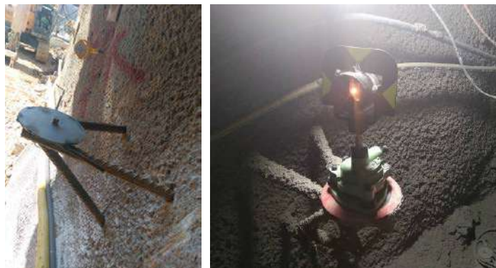
Слика 6. Стабилизација тачака подземне геодетске мреже у тунелу Мрке
