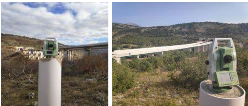
Слика 4. Изглед тачака надземне геодетске мреже на тунелу Мрке
