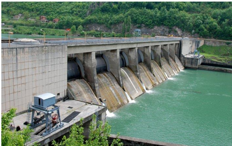
Слика 2: ХЕ Зворник, машинске зграде на боковима бране
